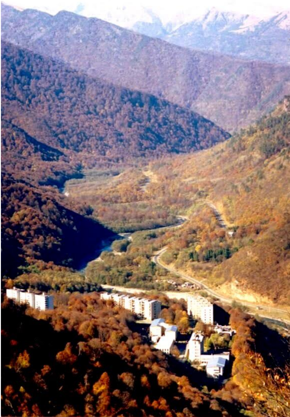
Рис. 1. Поселок Буково в ущелье Большого Зеленчука. Вид с востока.
